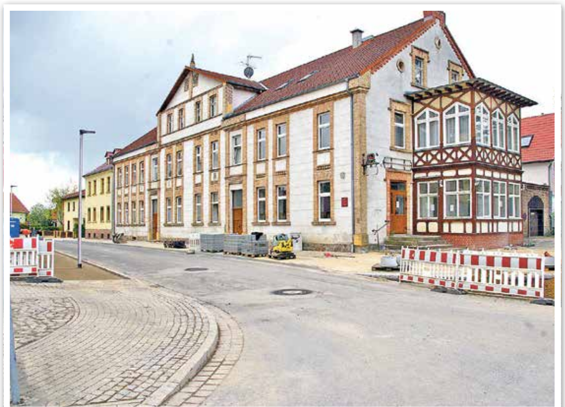
Blick auf die fast fertige Oderberger Straße
