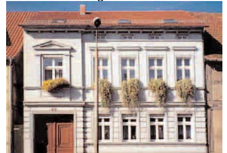
§ 6 (2) Putzfassade mit gliedernden Elementen
