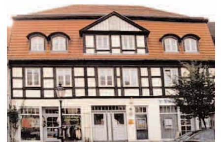
§ 7 (3) Schaufenster im konstruktiven Raster
