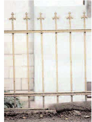
§ 12 (1) Mauerwerkssockel mit schmiedeeisernem Gitter und Pfeiler
