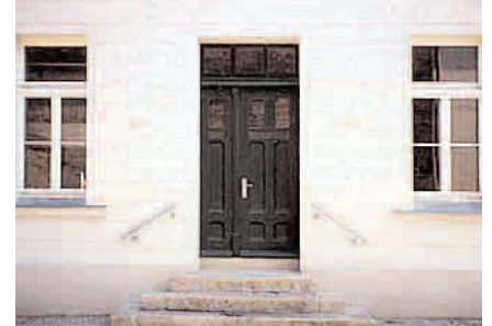
§ 7 (7) Eingangsstufen im Straßenraum mit Treppengeländer
